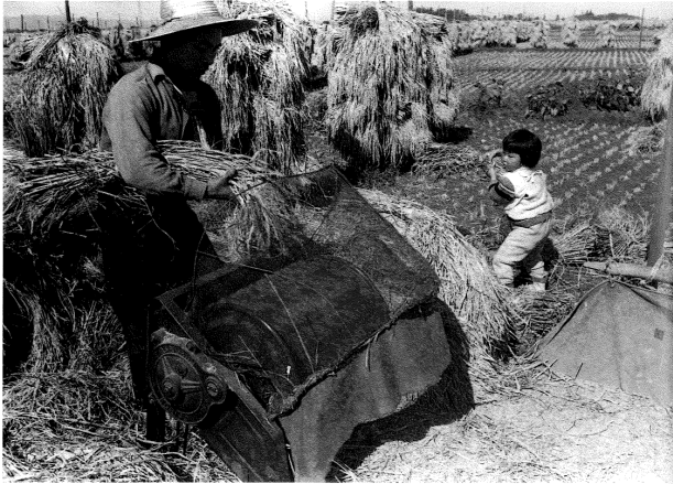
大正時代に普及した足踏み脱穀機。脱穀の能率は、千遍こまとはくらべものにならないほどであった。足踏み脱穀機を動かすゴーン、ゴーンという音が長くいつまでも聞こえる年は豊作だった。秋田県湯沢市山田。昭和38年（1963）10月 撮影・佐藤久太郎
