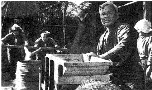
大正時代に普及した足踏み脱穀機。脱穀の能率は、千遍こまとはくらべものにならないほどであった。足踏み脱穀機を動かすゴーン、ゴーンという音が長くいつまでも聞こえる年は豊作だった。秋田県湯沢市山田。昭和38年（1963）10月 撮影・佐藤久太郎
