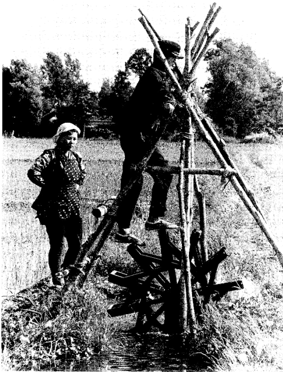
水車の羽を踏みまわし、田水路の水を田にばき回す。手押しという。せきくみあげ（せきいこ）。（14/頁）くくらべると 高だが、それでも20分前後で完了する。秋田県秋田市八幡。昭和33年（1958）8月。撮影・佐藤久太郎
